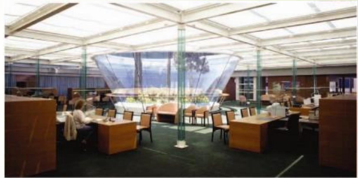
Poutres en verre au Centre de Recherches et de Restauration des musées de France (Louvre - Paris) 11 poutres supportant chacune 14 tonnes
