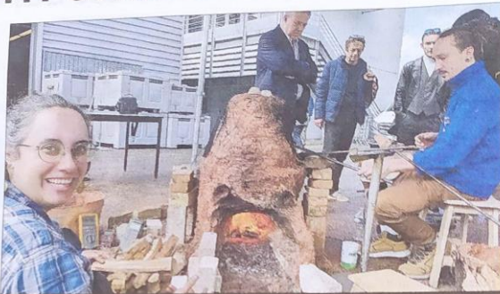
GRANDEUR NATURE. Une construction en terre, sable et paille, avec une partie réfractaire et une autre isolante. Alimenté régulièrement, ce four peut aller jusqu'à 1.000 degrés.
