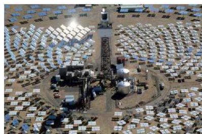
Tour de puissance \eta \approx 8-10\%
