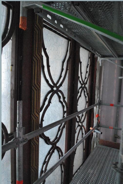
Verrière de protection Debitus posée en feuillure, vitraux placés en avancée dans une double-structure neuve.
